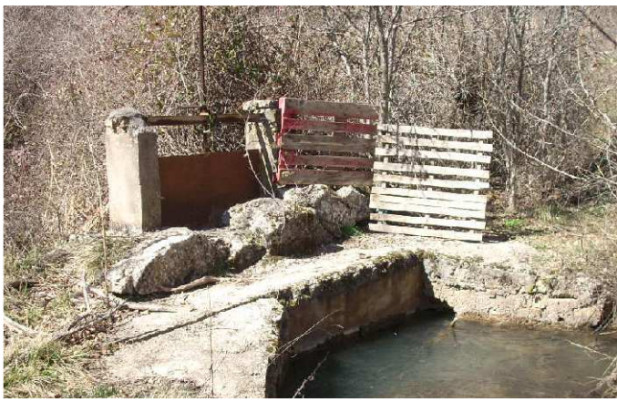
FOTO 3. Toma y canal del Azud Presa del Molino
